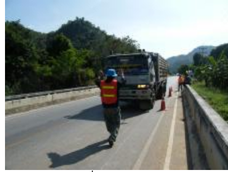
นำรถบรรทุกมาวิ่งทดสอบจริงและตรวจวัดพฤติกรรมของสะพานขณะทดสอบ
