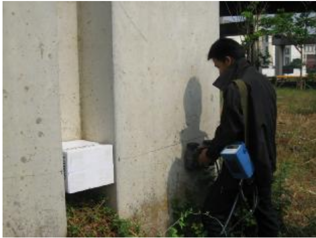
การทดสอบด้วยเครื่องมือ GPR
