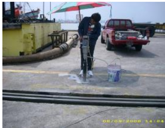
การเก็บตัวอย่างพื้นคอนกรีตโดยวิธี Coring
