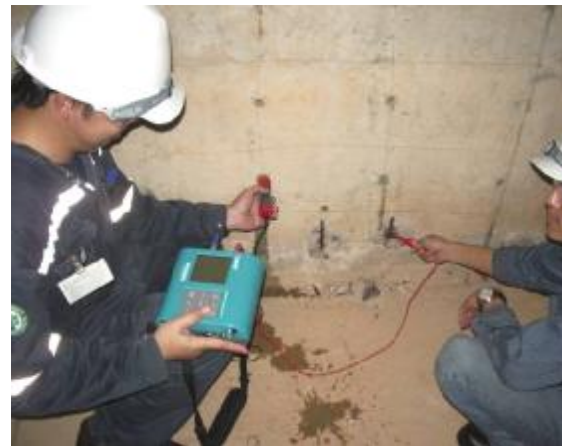
การทดสอบ Corrosion บนผนังคอนกรีต
