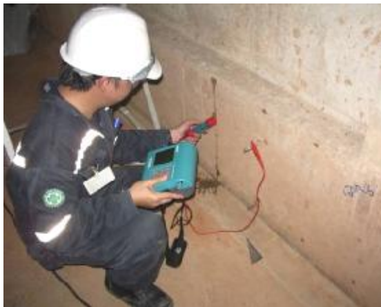
การทดสอบ Corrosion บนคานคอนกรีต
