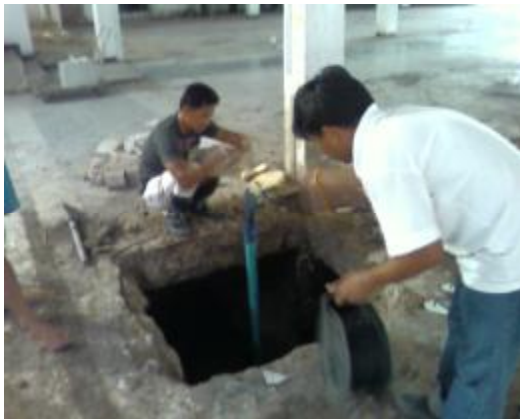
ภาพแสดงการทดสอบหาความยาวเสาเข็มโดยวิธี Parallel Seismic
