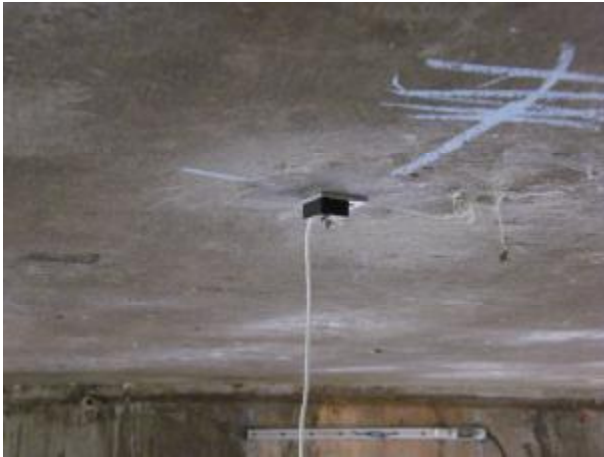
การติดตั้งอุปกรณ์วัดความเร่ง Accelerometer
