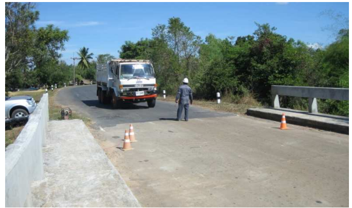
ภาพที่ 1 สะพานรูปแบบ Slab Type ที่ทำการทดสอบ
